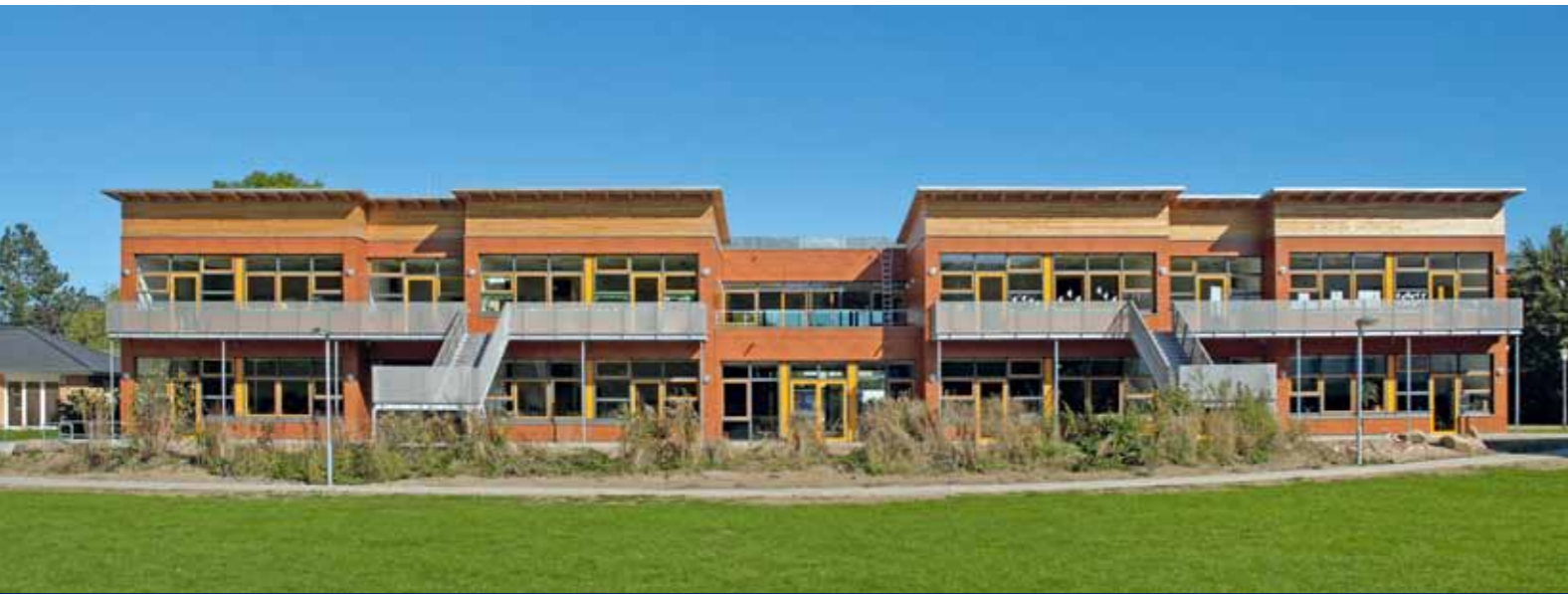
Die Claus-Rixen-Schule Grundschule Altenholz mit Außenstelle „Am Stifter Wald“ mit neuem Balkongeländer
