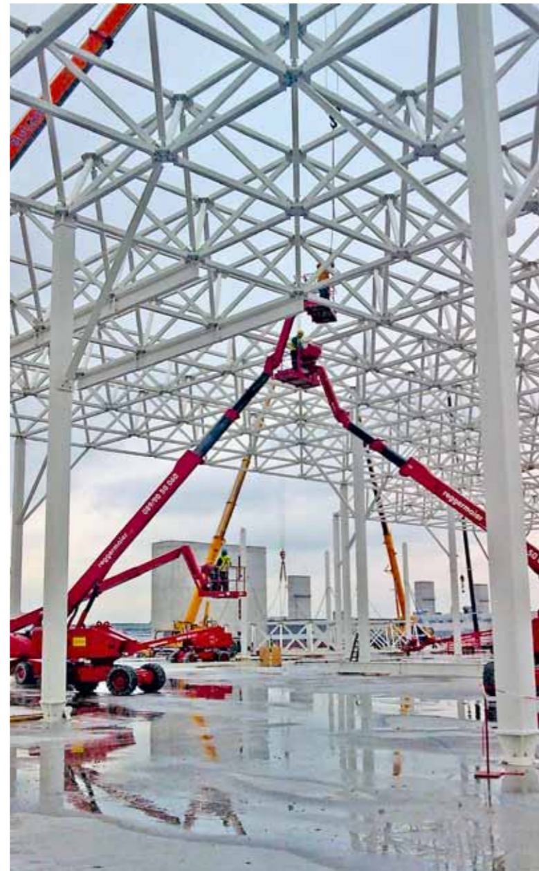
Das Raumfachwerk in Ingolstadt im Montagezustand
