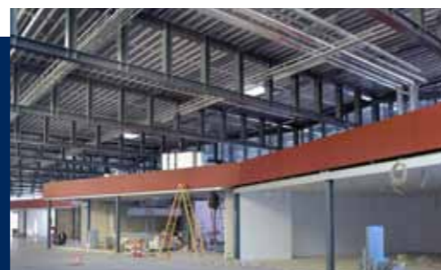
„Virendeel-Konstruktion“ für die Dachkonstruktion
