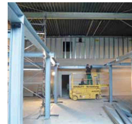
butzkies-Monteur richten das Stahlgerüst. Der Ausbau (s. o.) wird in diesem Jahr abgeschlossen sein.
